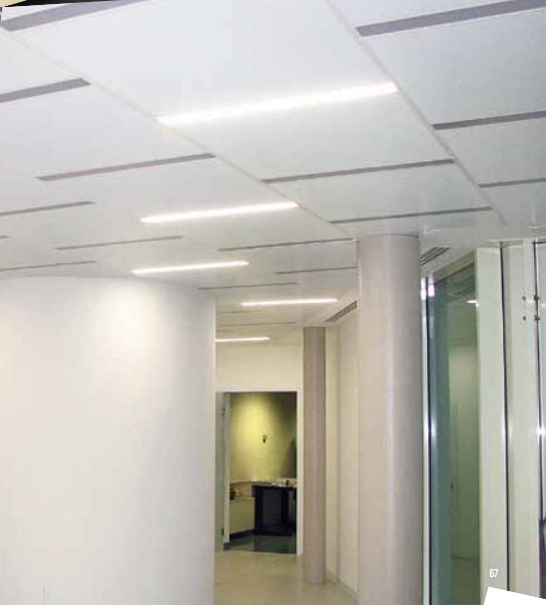
Controsoffitto metallico in acciaio realizzato a misura con luci a LED (Casalgrande, Reggio Emilia) ◀
