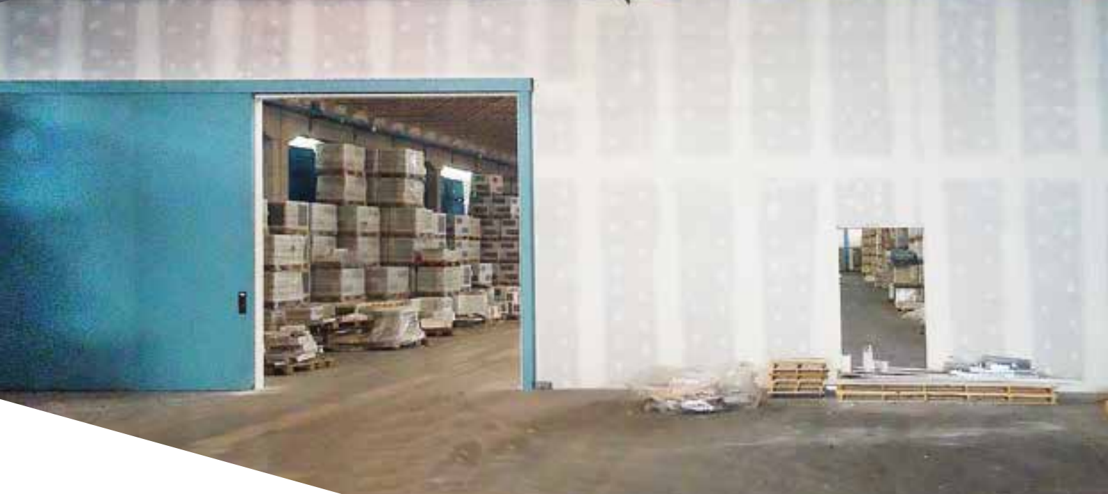
▲ Realizzazione di parete EI 120 dimensionata a misura per grandi altezze, con installazione carpenteria metallica per sostegno portone tagliafuoco REI 120 scorrevole. (Casalgrande - Reggio Emilia)
